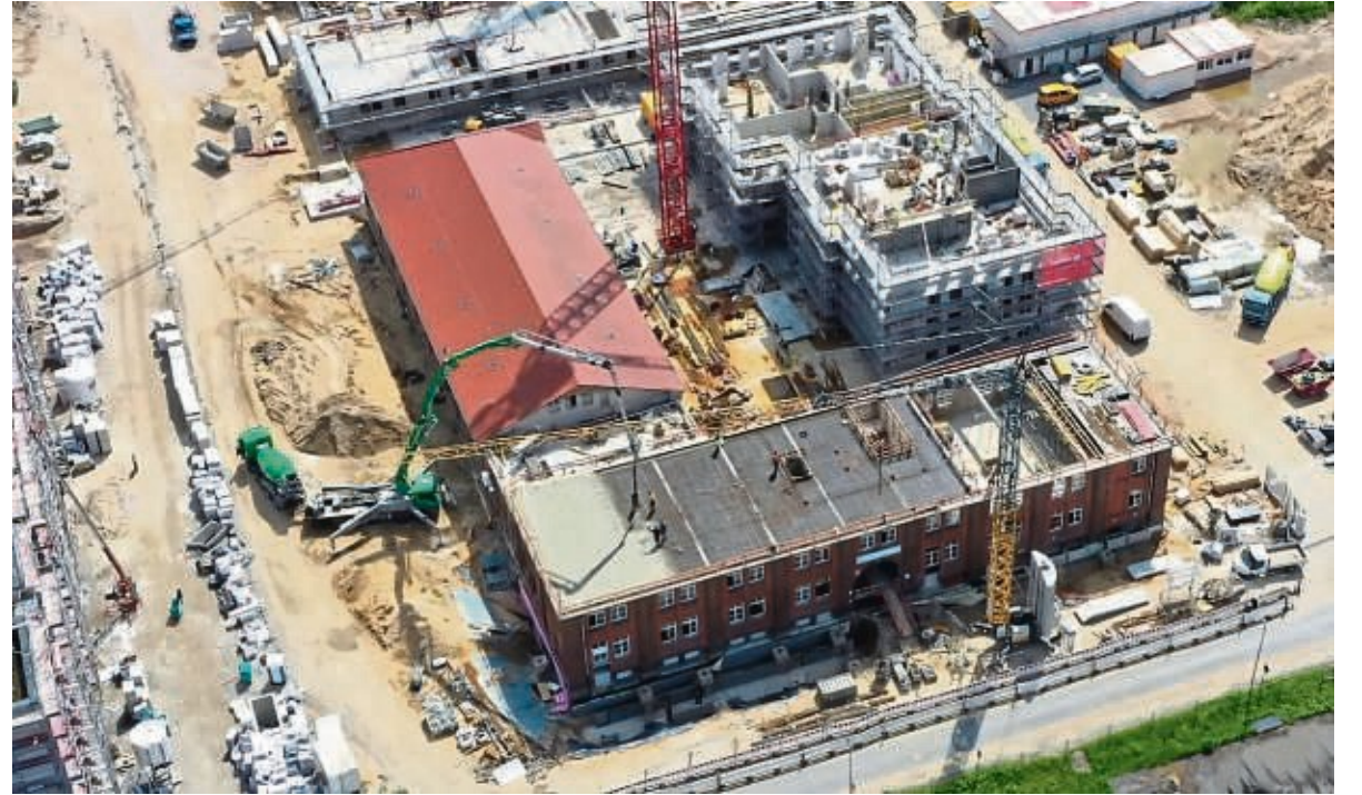
Wie der Umbau des historischen Branntweinmonopolgebäudes in die neue Kita fürs Quartier Süd voranschreitet, zeigen neue Drohnenaufnahmen von Hans-Walter Schewe. Links der Blick ins Innere: In der Bildmitte gibt es einen Einblick in den zweiten Stock, bevor die Decke eingeschalt wird; am linken Bildrand ist die Unterkonstruktion der Decke zu sehen. Rechts eine Drohnenansicht beim Betonieren der letzten Decke am Mittwoch.
