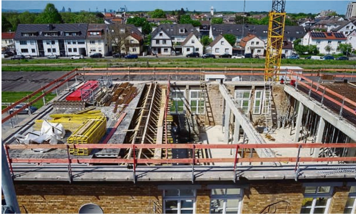
Wie der Umbau des historischen Branntweinmonopolgebäudes in die neue Kita fürs Quartier Süd voranschreitet, zeigen neue Drohnenaufnahmen von Hans-Walter Schewe. Links der Blick ins Innere: In der Bildmitte gibt es einen Einblick in den zweiten Stock, bevor die Decke eingeschalt wird; am linken Bildrand ist die Unterkonstruktion der Decke zu sehen. Rechts eine Drohnenansicht beim Betonieren der letzten Decke am Mittwoch.
